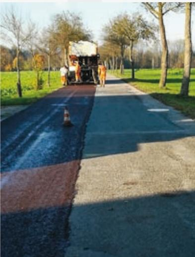
Vorprofilierung vor DSK-Einbau bei einer Zufahrtsstrasse
